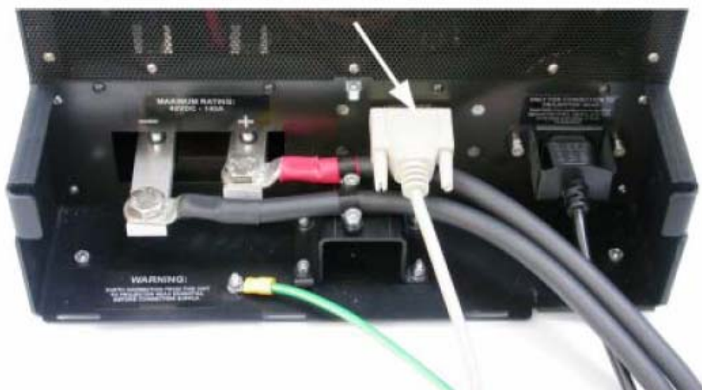
图9-8 安装机箱控制电缆
